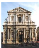
Sant'Andrea della Valle: l'angelo criticato è presente solo da un lato della facciata
